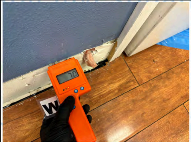
Main Hallway 1 - Drywall
