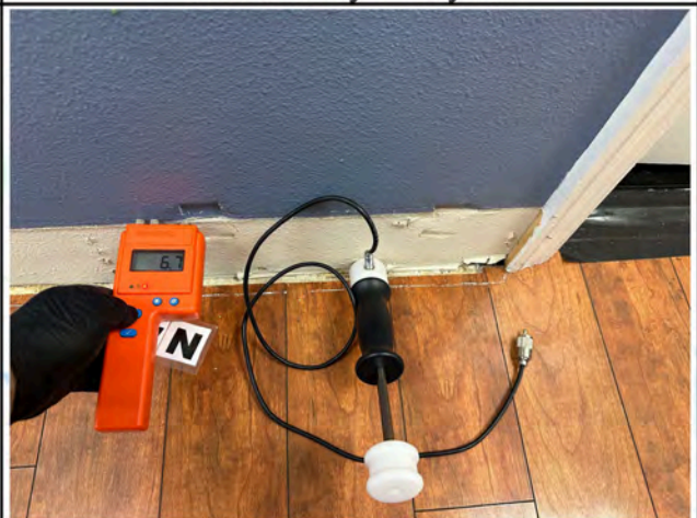
Main Hallway 2 - Drywall
